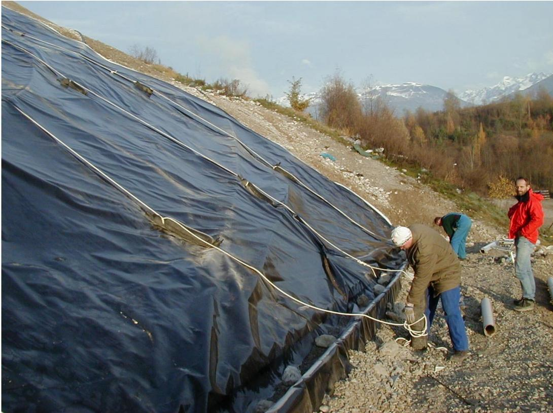
Abb. 2: Ableitung der Oberflächenwässer über Halbschale, Beschweren der Kunststoffhaut
