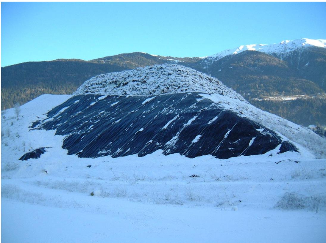
Abb. 3: Ausgestaltung der Dichthaut auch an Geländekanten und -mulden
